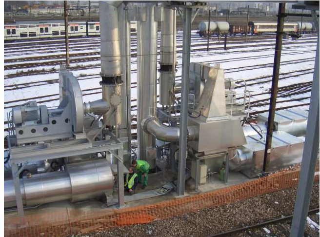
Bild 1 2GD's mit 960 mm Kantenlänge, Breite ca. 1000 mm, Objekt: Paris Absauganlage für Diesellokomotiven
