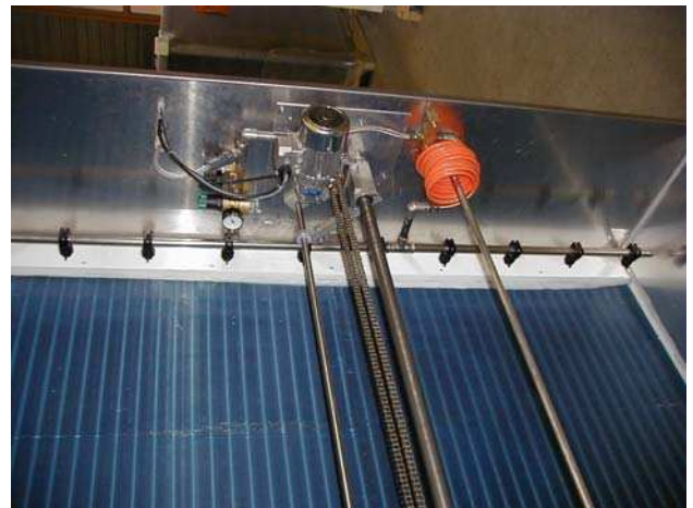
Bild 3/4: Glycol-Register, mit softcool-System, hydrophil beschichtete Lamellen, 16 Rohrreihen, liegende Anordnung, 30'000 m 3 /h
